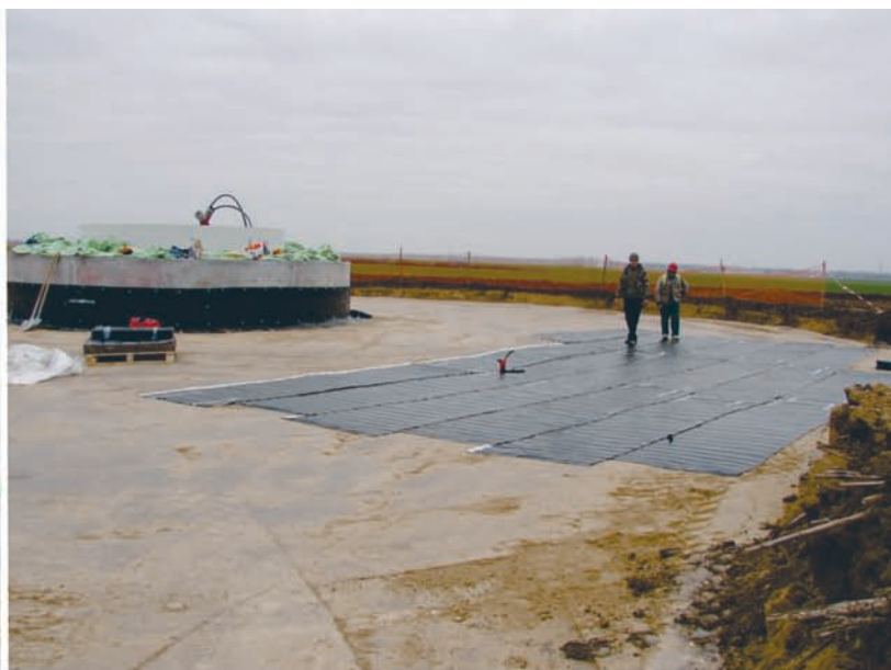
Foto 2: Instalare Voltex peste fundație
