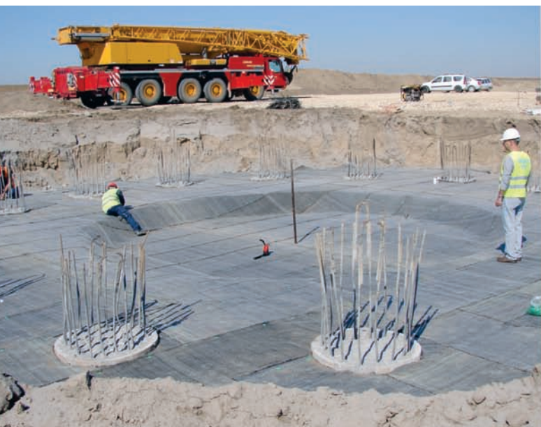
Foto 1: Instalare Voltex sub fundație
