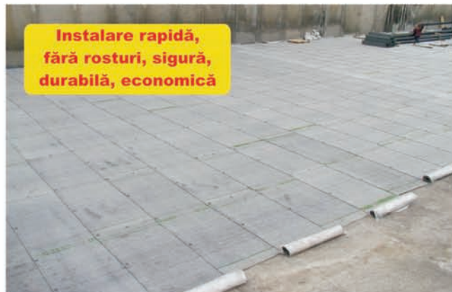
Aplicarea pe beton de egalizare
