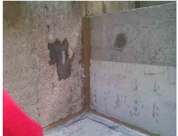
Realizarea scafelor cu granule de bentonita si reparatia defectelor mai mari de 2 cm adancime
