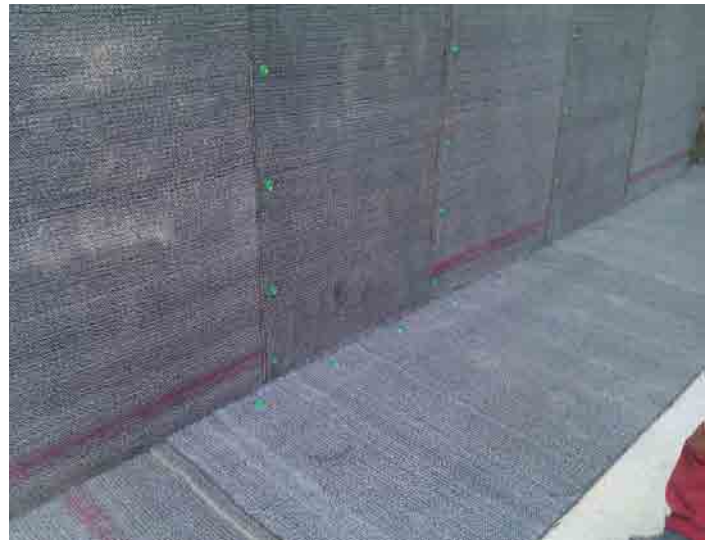
Montarea membranei Voltex in zona perimetrala
