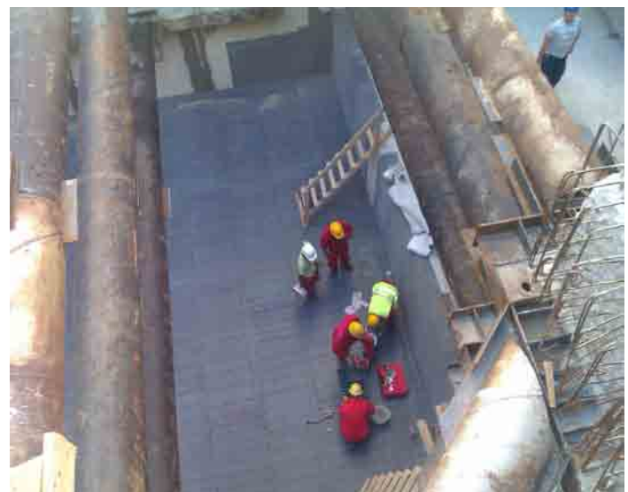
Fixarea mecanica a membranei Voltex in camp
